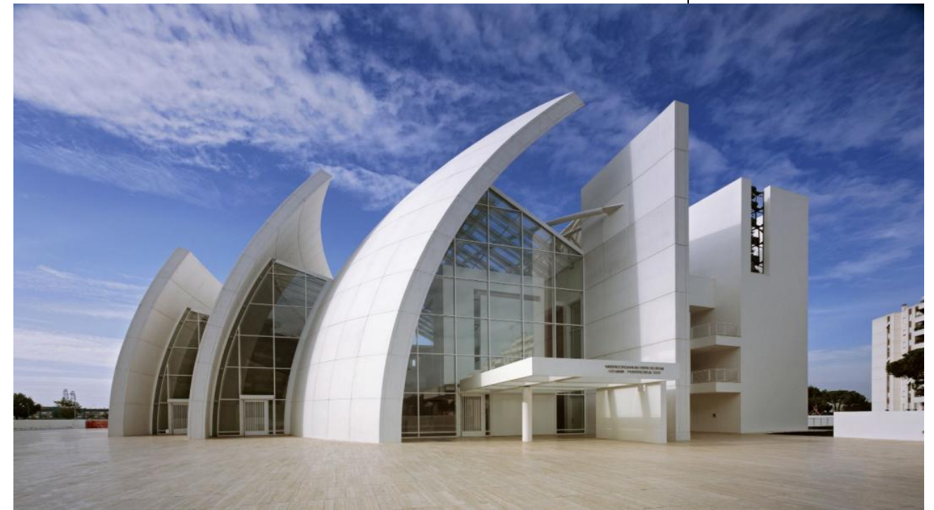
کلیسای جویولی در شهر رم ایتالیا که با استفاده از بتن فوتوکاتالیستی و خودتمیزشونده ساخته شده است.
